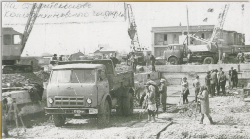
На строительстве Константиновского гидроузла. ЦДНИРО. Ф.Р-3619. Оп.7. Д.1419. Л.4
